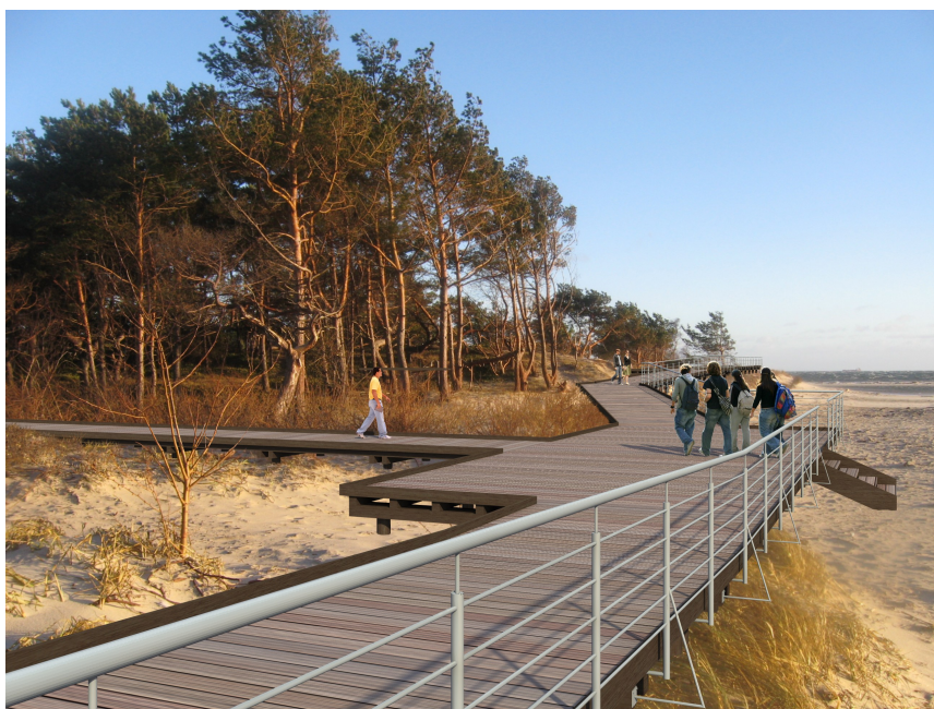
Widok kładki w rej. węzła nr 3
